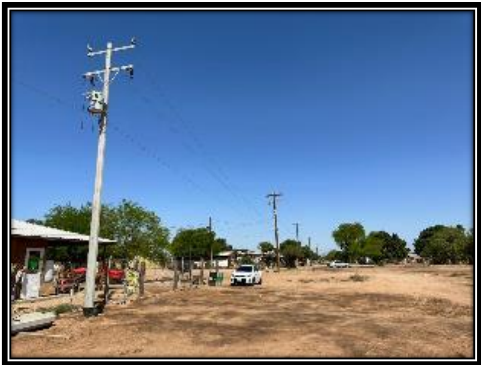
Supervisión de obra FAIS de la ampliación de electrificación en el Ejido Delta Oaxaca
